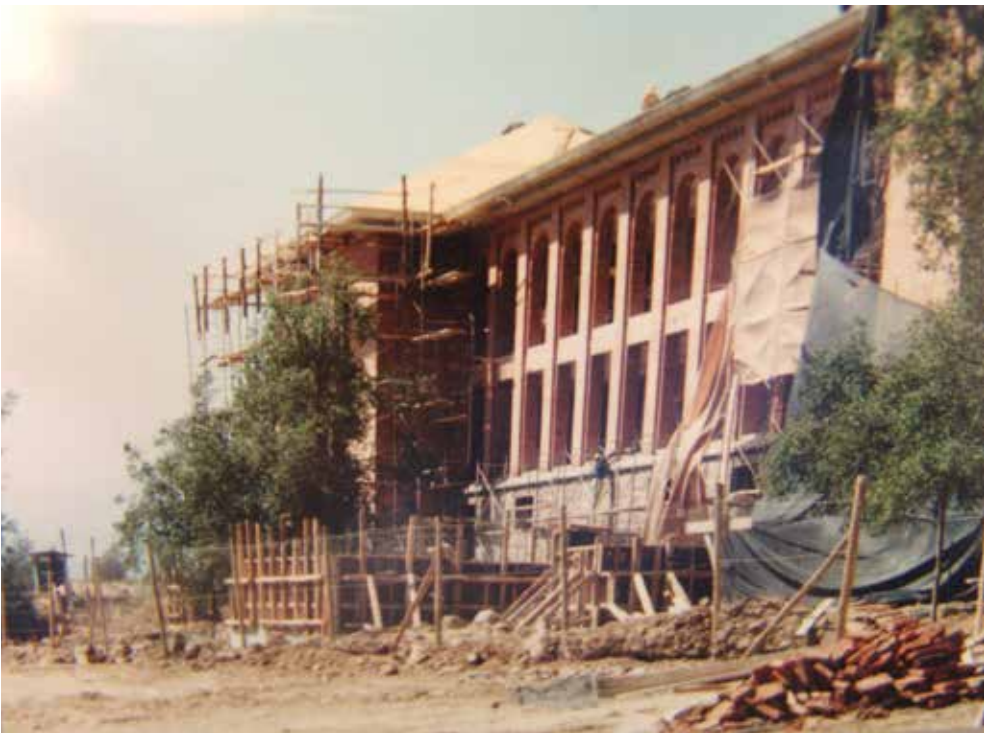
La fachada poniente del edificio de Humanidades en construcción, 1994.
