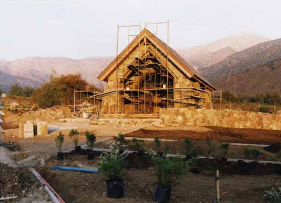
La construcción de la ermita en los jardines.
