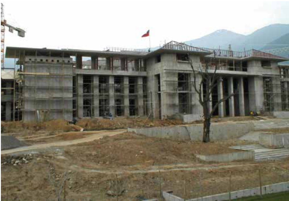
El edificio de Biblioteca en construcción, 2001.
