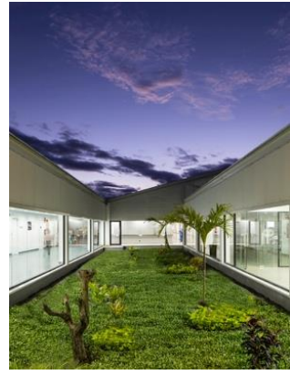
HOSPITAL DE PUYO, EQUADOR PMMT
