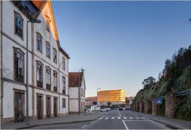
HOSPITAL TERRA QUENTE, MIRANDELA, PORTUGAL PITAGORAS GRUP
