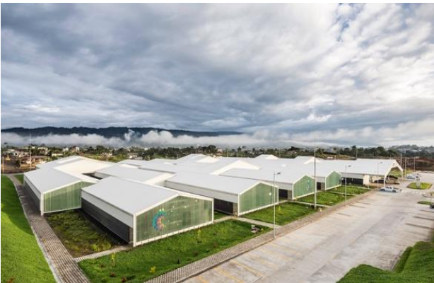
HOSPITAL DE PUYO, EQUADOR PMMT
